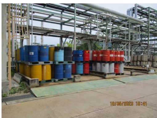
รูปที่ 3.32 Concrete Curb รอบพื้นที่เก็บพักของเสีย
