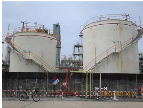
รูปที่ 3.43 คั่นคอนกรีต บริเวณถังเก็บกากเฮกเซน (TK-702, TK-703)
