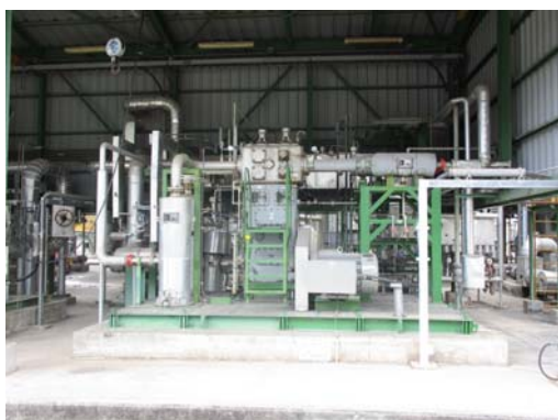
รูปที่ 3.4 Flash Gas Compressor (C-222)
