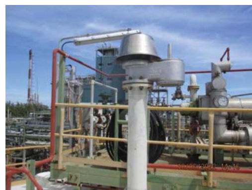
รูปที่ 3.5 ระบบท่อรวบรวม Vent Gas
