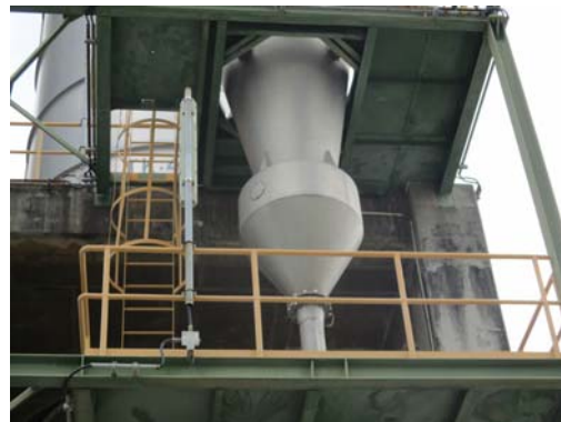
รูปที่ 3.7 เครื่องดักฝุ่นแบบไซโคลน (Cyclone)
