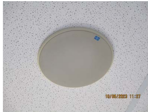
รูปที่ 3.47 ระบบ Acoustic Alarm
