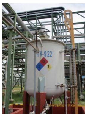
รูปที่ 3.44 คั่นคอนกรีต บริเวณถังเก็บกากโซเดียมไฮดรอกไซด์ (TK-922)
